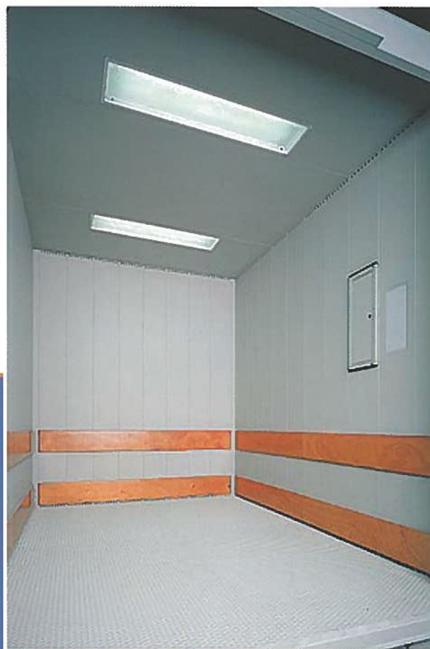
rivestimento della cabina in lamiera d'acciaio verniciato e paracolpi in legno
